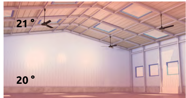
Wärmeverteilung mit Wärmerückführung
